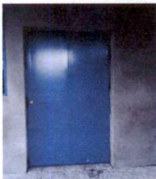
FOTO 3 SUSTITUCIÓN DE PUERTA DE METAL
