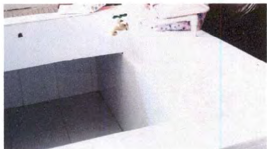
Foto 9: INSTALACION DE TUBERIA PRINCIPAL PVC PARA PILETA
