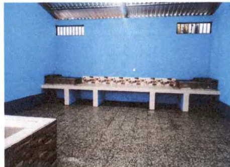
Foto 8: INSTALACION DE PISO DE GRANITO
