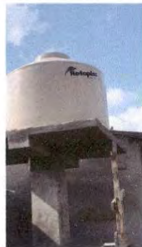
Foto 2: INSTALACION DE ROTOPLAZ DE 2500 LTS
