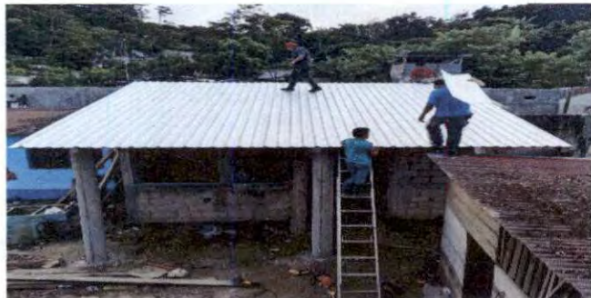
FOTO 1: SUSTITUCIÓN DE LAMINA, POR LAMINA TROQUELADA ALUZIN CALIBRE 26
