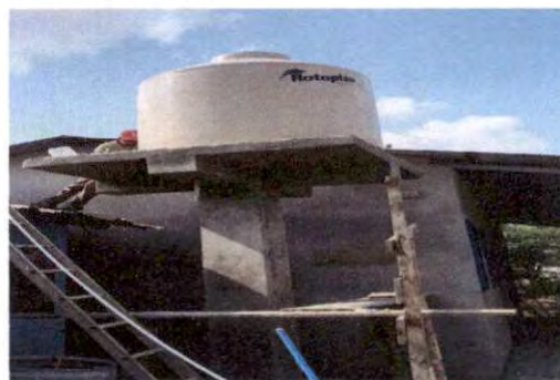
FOTO 4 SUSTITUCIÓN DE DEPÓSITO DE AGUA DE 1700 LT
