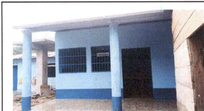
Foto 7: FABRICACION DE COLUMNAS Y TECHO
