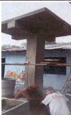
Foto 1: FABRICACION DE COLUMNA PARA ROTOPLAZ
