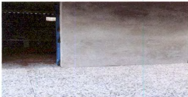
FOTO 5 SUSTITUCIÓN DE PISO DE GRANITO
