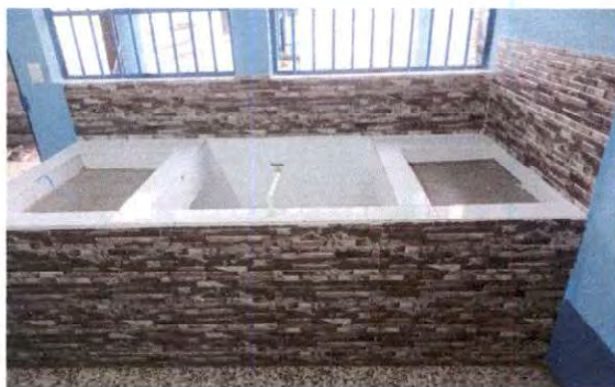
Foto 3: FABRICACION DE PILETA
