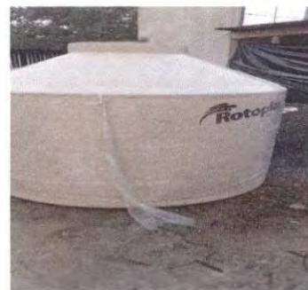
FOTO 4: SUSTITUCION DE DEPOSITO DE AGUA DE 1700 LT
