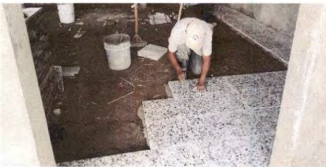
FOTO 5: SUSTITUCION DE PISO DE GRANITO
