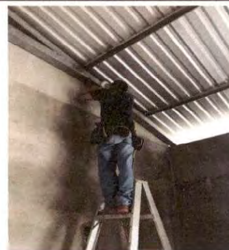
Foto 10: INSTALACION DE ENERGIA ELECTRICA
