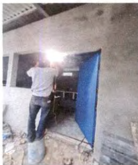
FOTO 3: INSTALACION DE PUERTA DE METAL
