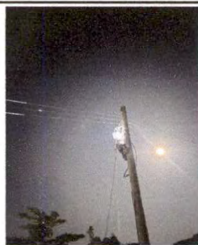
Foto 11: INSTALACION DE LAMPARA EN POSTE
