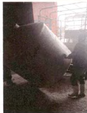
Foto 2: INSTALACION DE ROTOPLAZ DE 2500 LTS
