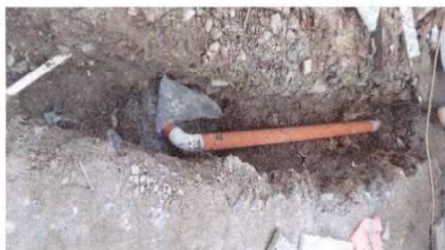
Foto 9: INSTALACION DE TUBERIA PRINCIPAL PVC PARA PILETA
