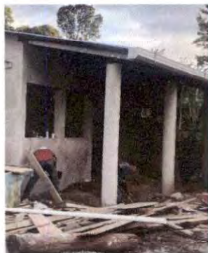
Foto 7: FABRICACION DE COLUMNAS Y TECHO
