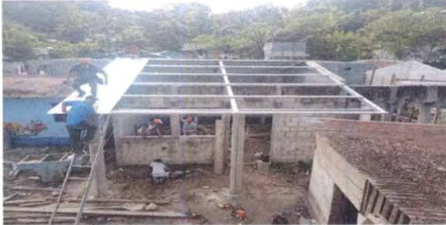
FOTO 1: SUSTITUCION DE LAMINA, POR LAMINA TROQUELADA ALUZIN ALIBRE26
