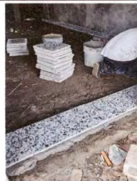
Foto 8: INSTALACION DE PISO DE GRANITO
