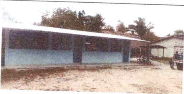
Foto 3: PINTURA EN PAREDES INTERIOR Y EXTERIOR
