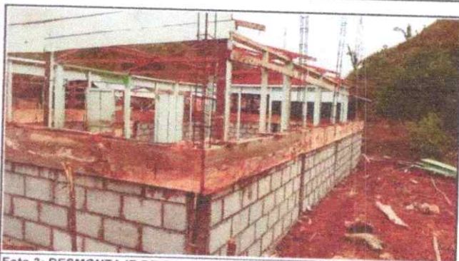
Foto 3: DESMONTAJE DE PAREDES
