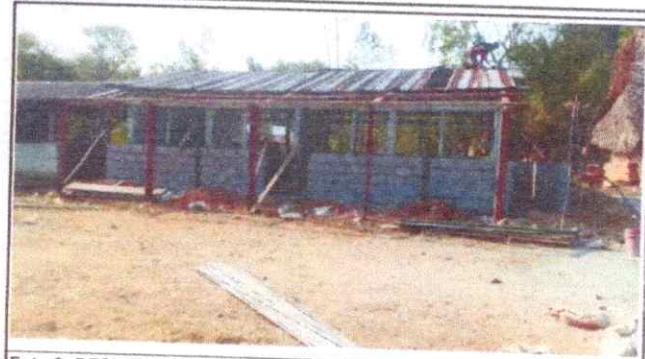
Foto 2: DESMONTAJE DE TECHO DE AULAS
