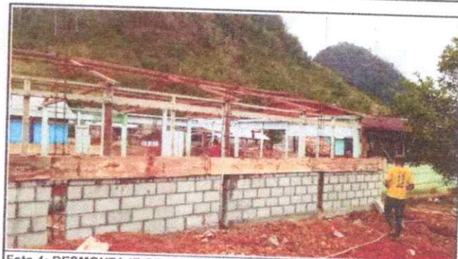
Foto 4: DESMONTAJE DE PAREDES
