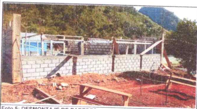
Foto 5: DESMONTAJE DE PAREDES
