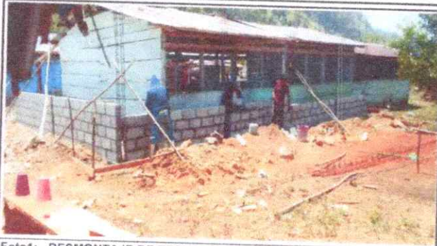
Foto 1: DESMONTAJE DE TECHO DE AULAS
