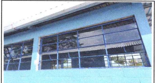
FOTO 4: SUSTITUCIÓN DE VIDRIOS, SUSTITUCIÓN DE BALCONES DE METAL
