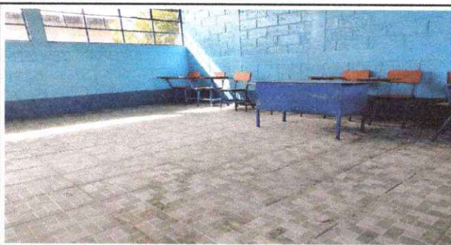
FOTO 5: SUSTITUCIÓN DE PISO CERÁMICO
