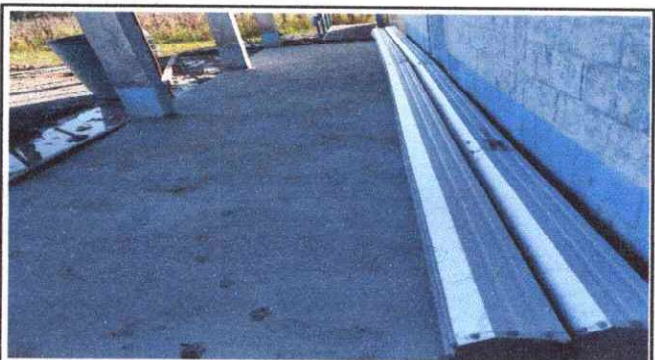
FOTO 11: REPARACIÓN DE PLANCHAS DE CONCRETO DE PATIO
