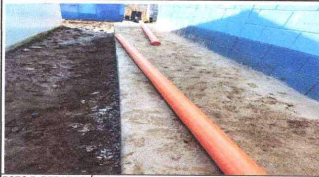
FOTO 7: REPARACIÓN DE BANQUETA DE CONCRETO
