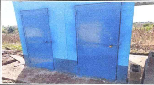
FOTO 9: PINTURA A PUERTAS SERVICIOS SANITARIOS
