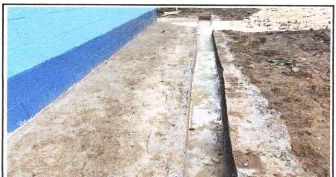
FOTO 6: REPARACIÓN DE CUNETA DE CONCRETO
