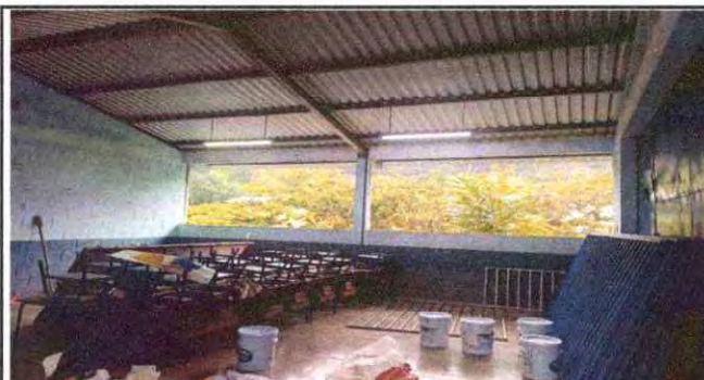
Foto 4: SUSTITUCIÓN DE BALCON DE HIERRO.
