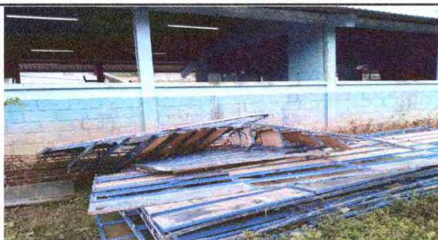
Foto 3: SUSTITUCIÓN DE BALCON DE HIERRO.
