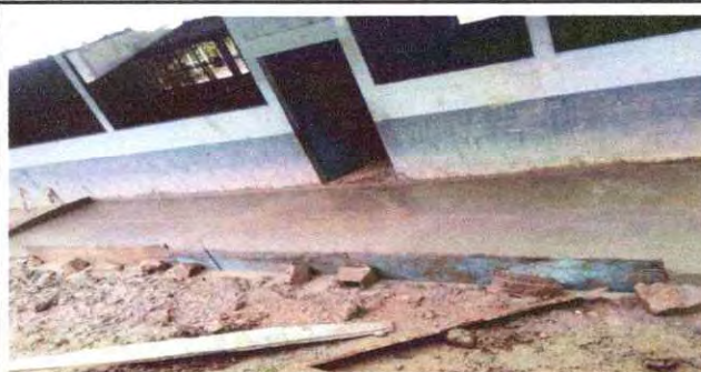
Foto 2: REPARACIÓN DE TORTA DE CONCRETO.
