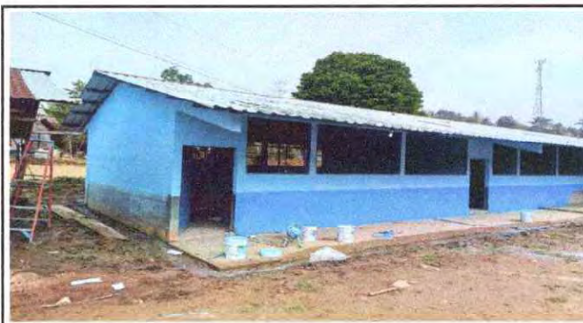
Foto 10: PINTURA EN MUROS INTERIORES Y EXTERIORES.
