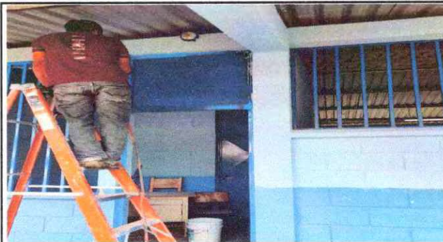
Foto 8: MANTENIMIENTO A ESTRUCTURA DE PUERTA DE METAL.
