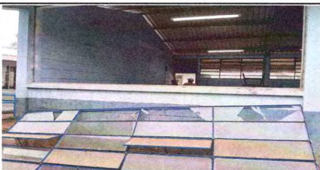
Foto 5: SUSTITUCIÓN DE BALCÓN DE HIERRO.
