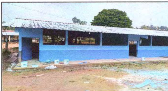
Foto 9: PINTURA EN MUROS INTERIORES Y EXTERIORES.
