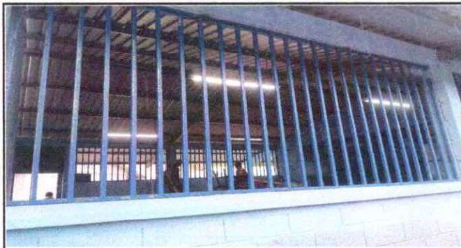
Foto 13: SUSTITUCIÓN DE LAMPARA TIPO LED
