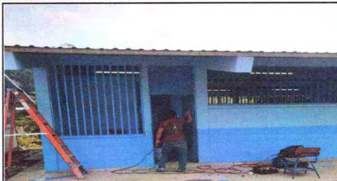
Foto 7: MANTENIMIENTO A ESTRUCTURA DE PUERTA DE METAL.
