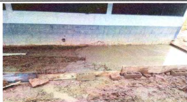
Foto 1: REPARACIÓN DE BANQUETA DE CONCRETO.
