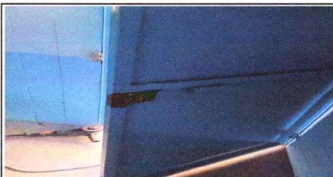
Foto 12: SUSTITUCIÓN DE CHAPA
