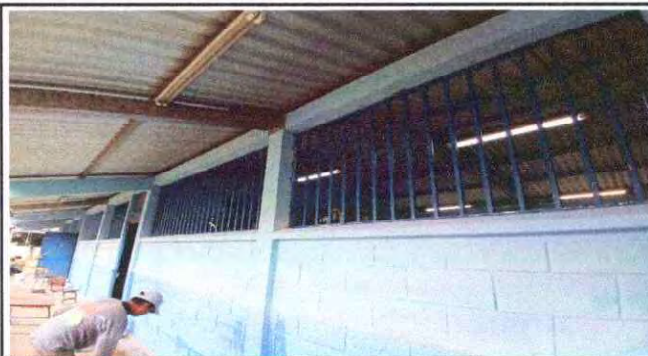
Foto 14: SUSTITUCIÓN DE LAMPARA TIPO LED
