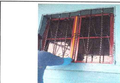
FOTO 5: sustitución de ventana de madera por metal mas vidrio
