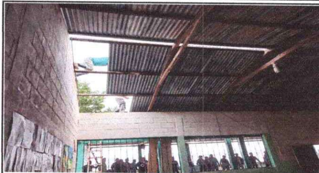
FOTO 1: Sustrucción de laminas, por laminas troquelada aluzinc calibre 26
