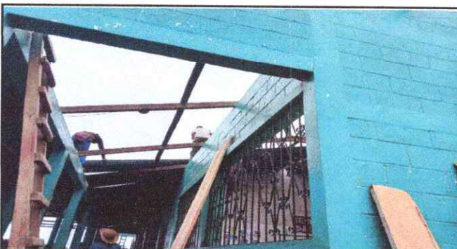
FOTO 3: Sustrucción de elementos de fijación, Sustrucción de capote de lamina para lamina troquelada
