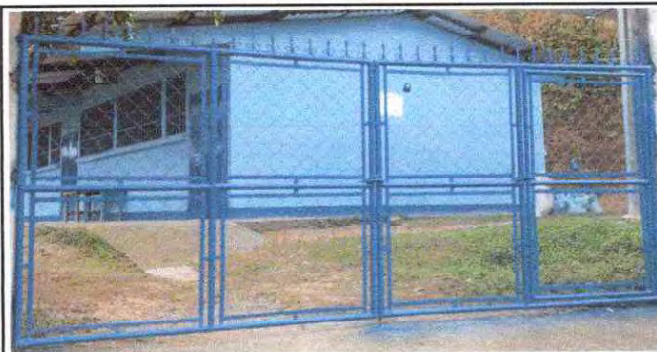
Foto 12: Mantenimiento a portón de metal
