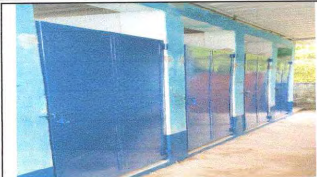
Foto 7: Sustitución de puertas en servicio sanitario
