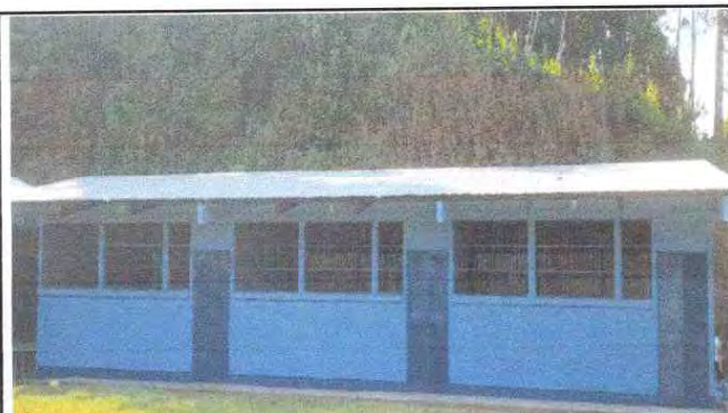
Foto 4: Mantenimiento a estructura de puertas de metal.
