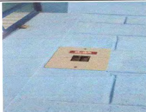
Foto 14: Reparacion de Cableado Eléctrico-
