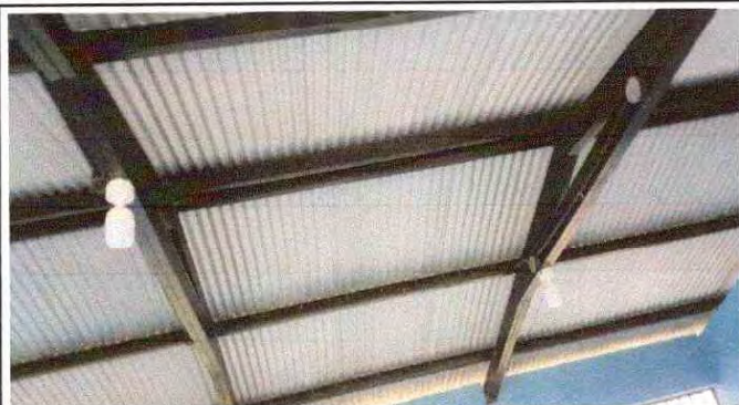
Foto 13: Sustrucción de lámparas tipo led.
