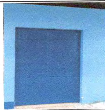
Foto 6: Sustitución de puertas.
