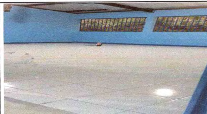
Foto 10: Sustitución de piso cerámico
