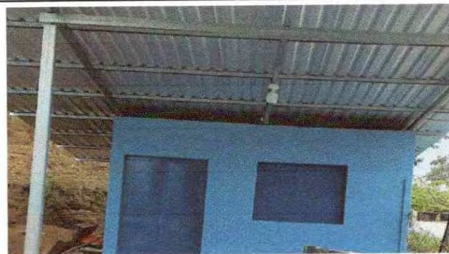
Foto 8: Sustitución de ventanas de madera por metal
