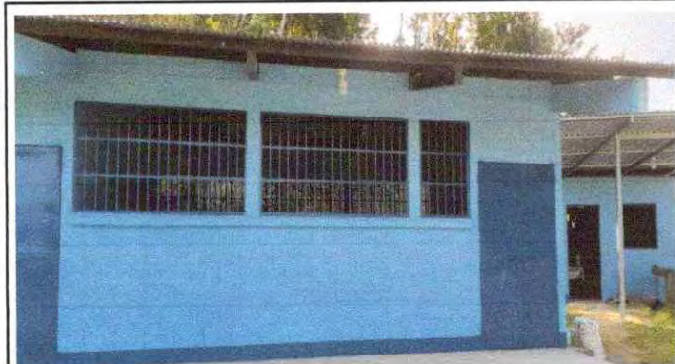
Foto 9: Sustitución de Balcones de metal.
