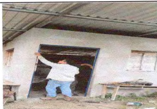
Foto 6: Sustitución de puertas.
