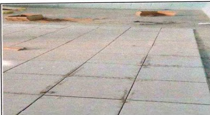
Foto 10: Sustitución de piso cerámico
