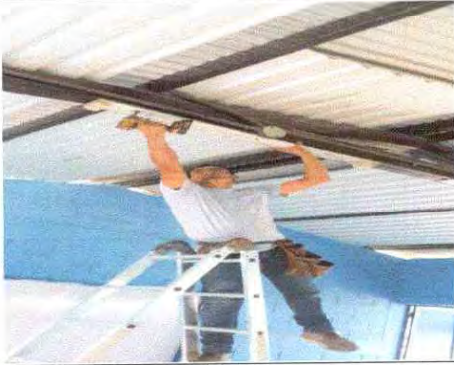
Foto 13: Sustitución de lámparas tipo led.
