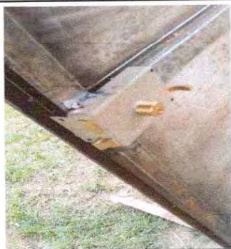
Foto 5: Sustitución de chapa.
