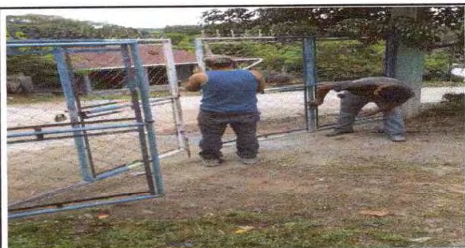
Foto 12: Mantenimiento a portón de metal
