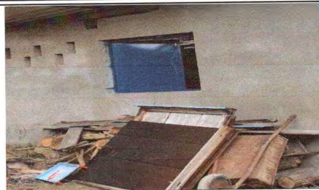
Foto 8: Sustitución de ventanas de madera por metal
