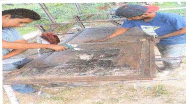
Foto 4: Mantenimiento a estructura de puertas de metal.
