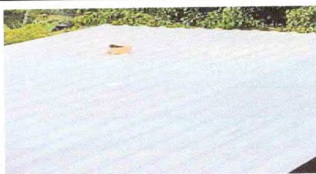
Foto 2: Sustitución de elementos de fijación.
