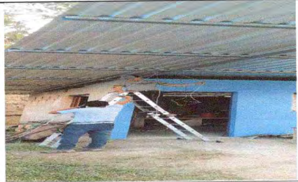
Foto 14: Reparación de Cableado Eléctrico-
