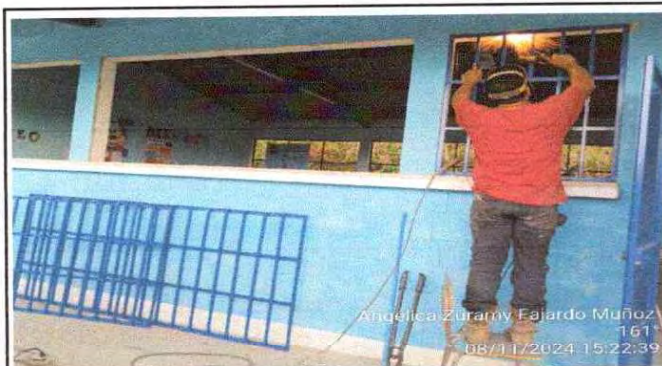
Foto 9: Sustitución de Balcones de metal.
