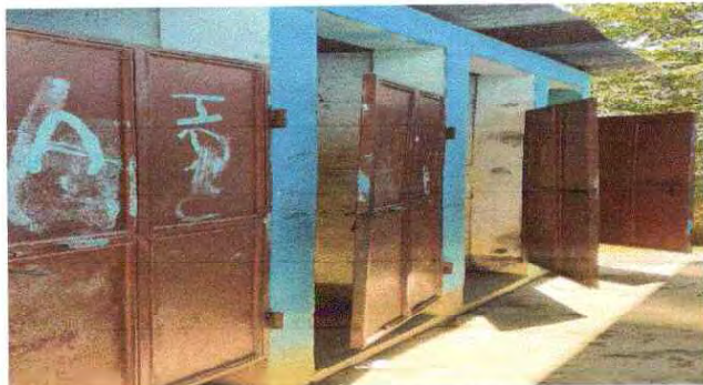
Foto 7: Sustitución de puertas en servicios sanitarios.
