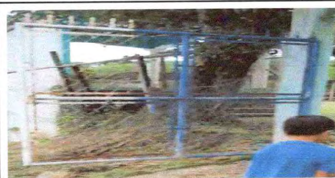
Foto 12: Mantenimiento a portón de metal.
