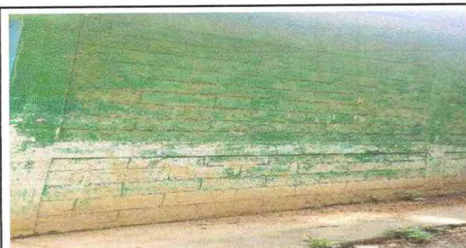
Foto 11: Pintura en muros exteriores e interiores.
