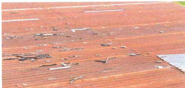
Foto 2: Sustitución de elementos de fijación.
