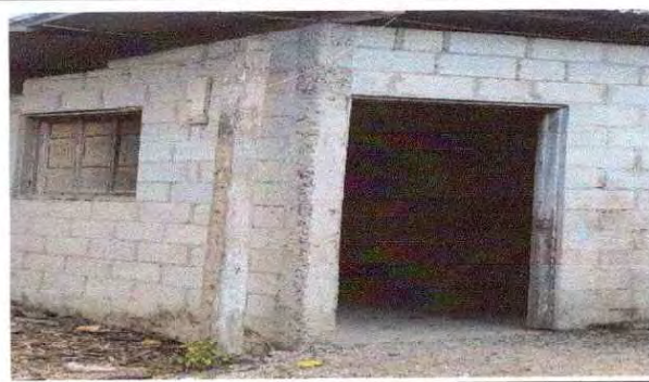
Foto 6: Sustitución de puertas.
