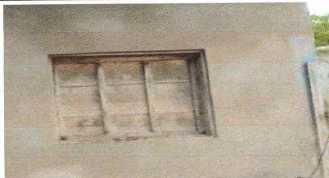
Foto 8: Sustitución de ventanas de madera por metal
