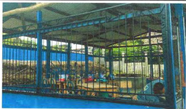
Foto11:SUSTITUCION DE BALCONES DE METAL
