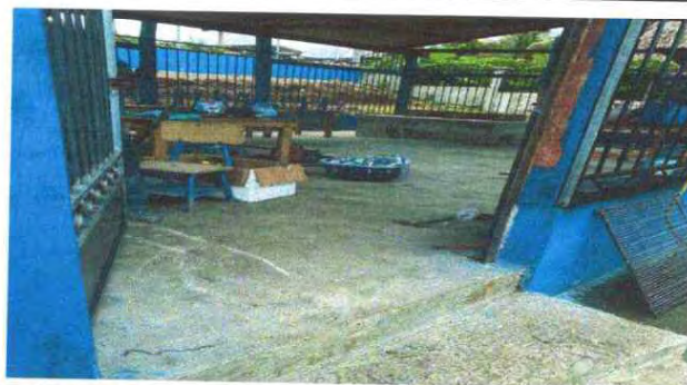
Foto 6: SUSTITUCION DE PISO DE TORTA DE CONCRETO
