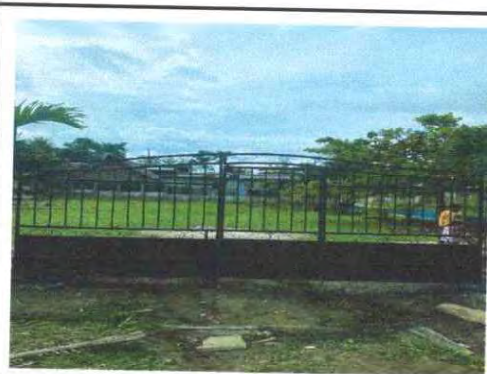
Foto 12: MANTENIMIENTO DE PORTON DE METAL
