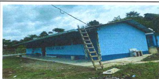
Foto7: PINTURA MUROS INTERIOR Y EXTERIOR
