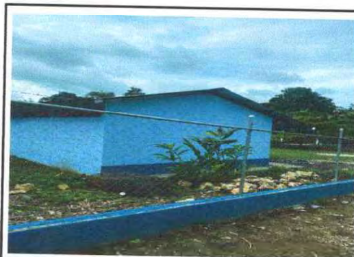
Foto 13: REPARACION DE TUBO HG Y MALLA GALVANIZADA
