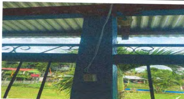
Foto 4: SUSTITUCION DE INTERRUPTORES SIMPLES
