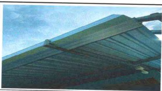
Foto 16: SUSTITUCION DE CANAL DE METAL
