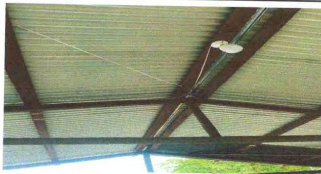
Foto 2: REPARACION DE CABLEADO ELECTRICO
