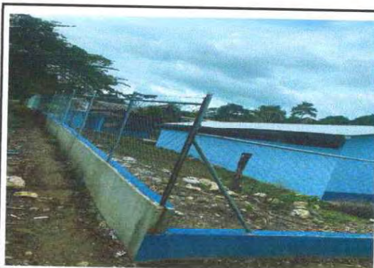
Foto 14: MANTENIMIENTO DE MURO PERIMETRAL DE BLOCK
