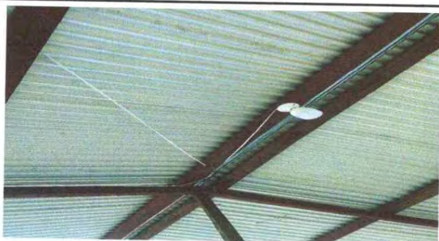
Foto 3: SUSTITUCION DE PLAFONERA
