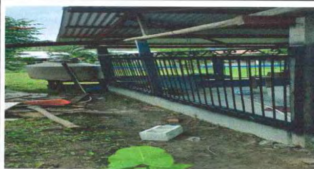
Foto 10:INSTALACION DE TUBERIA PRINCIPAL DE PVC
