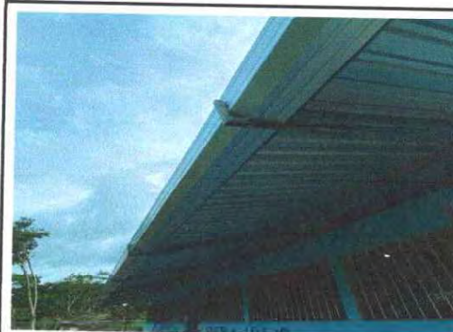
Foto 15: SUSTITUCION DE SOPORTE O PESCANTE DE METAL PARA CANAL
