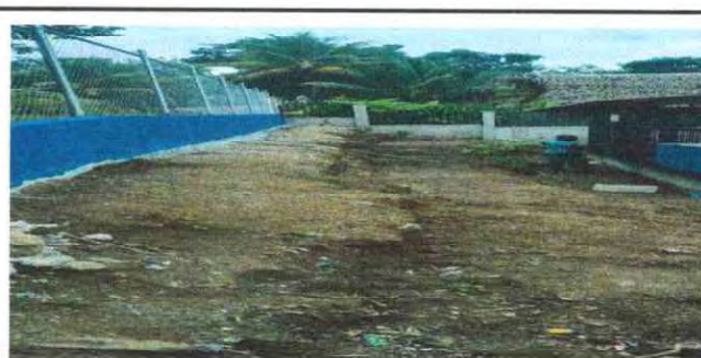
Foto 8:SUSTITUCION TUBERIA LINEAL PRINCIPAL
