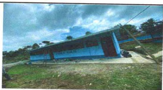
Foto 16: SUSTITUCION DE CANAL DE METAL
