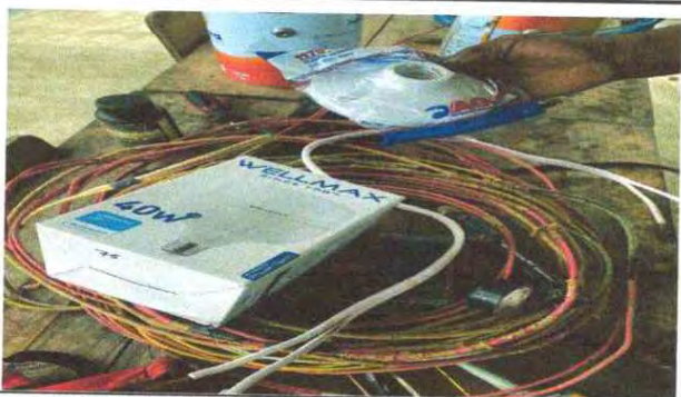
Foto 5: SUSTITUCION DE LAMPARA TIPO LED
