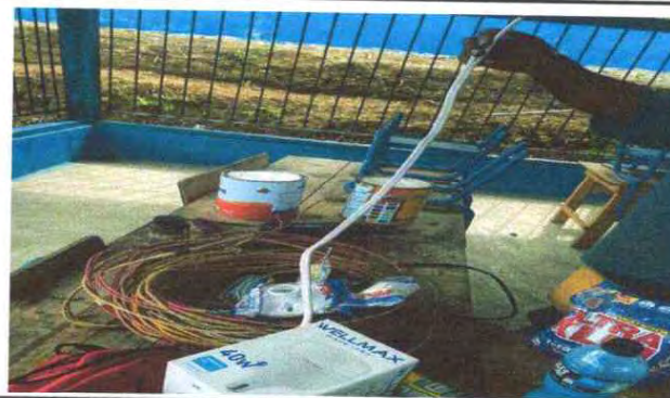
Foto 2:REPARACION DE CABLEADO ELECTRICO
