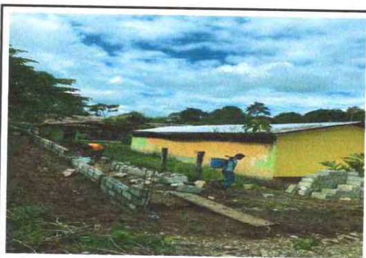
Foto 14: MANTENIMIENTO DE MURO PERIMETRAL DE BLOCK
