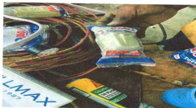
Foto 4: SUSTITUCION DE INTERRUPTORES SIMPLES
