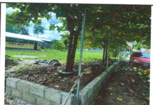
Foto 13: REPARACION DE TUBO HG Y MALLA GALVANIZADA
