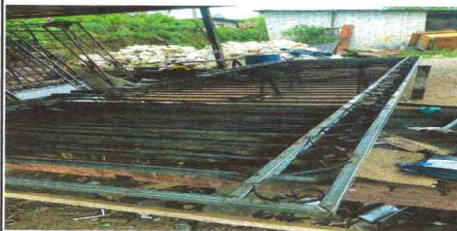
Foto11:SUSTITUCION DE BALCONES DE METAL
