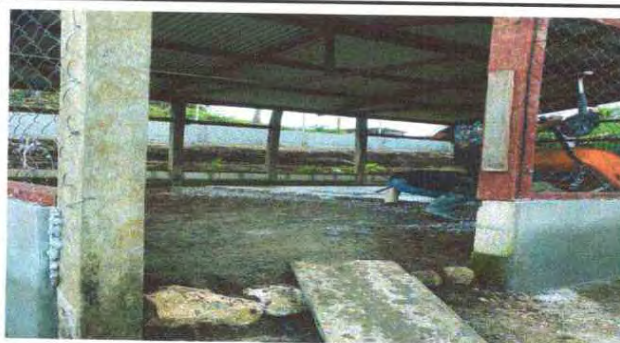
Foto 6: SUSTITUCION DE PISO DE TORTA DE CONCRETO
