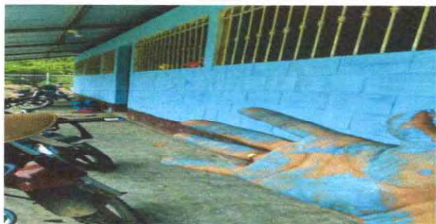
Foto7: PINTURA MUROS INTERIOR Y EXTERIOR
