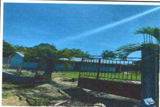
Foto 12: MANTENIMIENTO DE PORTON DE METAL
