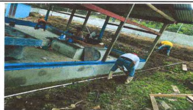
Foto 10:INSTALACION DE TUBERIA PRINCIPAL DE PVC
