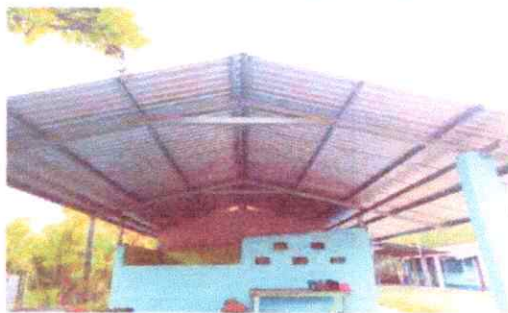
Foto 5: De mediana distancia que muestra el techo de lamina zinc ya instalado en la cocina.
