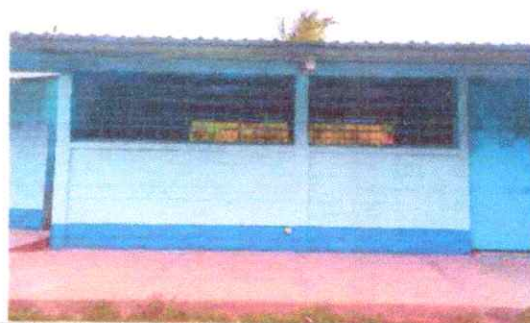
Foto 6: de mediana distancia que muestra los balcones y la puerta del aula, ya terminados
