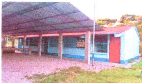
Foto1: Panorámica que muestra Balcones y puerta ya terminados
