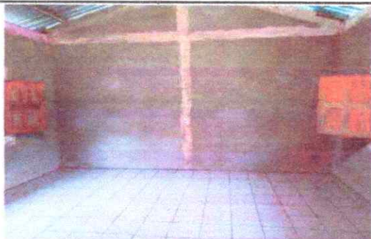
Foto 3: De mediana distancia que muestra el interior del aula, ya con ceramico y repellada.
