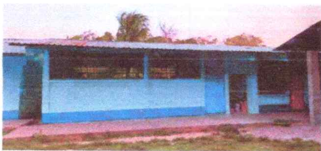
Foto 5: Panoramica que muestra los balcones y la puerta del aula, ya terminados
