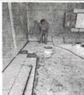
Foto 4: De mediana distancia que muestra el momento en que proceden a pegar el cerámico
