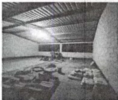
Foto 3: De mediana distancia que muestra el momento en que proceden a pegar el cerámico en el aula
