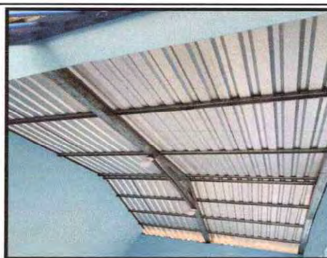
Foto 4: Instalación de Estructura portante
