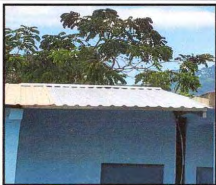
Foto 15: Sustitución de lámina aluzinc
