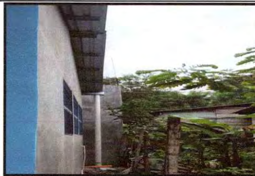
Foto 18: Sustitución de bajada de agua pluvial de metal por tubo PVC 3"
