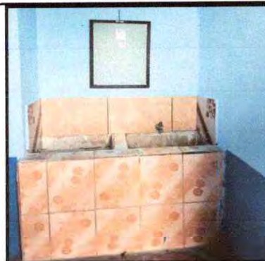
Foto 28: Instalación de azulejo en pila de baños
