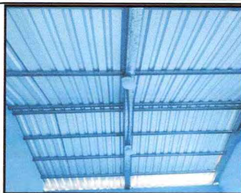
Foto 2: Instalación de lámina troquelada aluzinc en cocina
