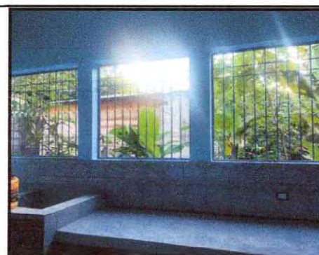
Foto 6: Sustitución de balcones de metal en cocina
