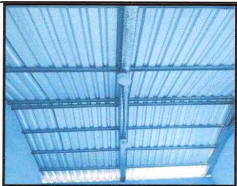
Foto 1: Sustitución de lámina por lámina troquelada aluzinc calibre 26 en en cocina
