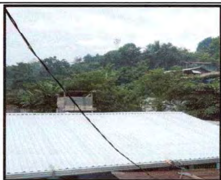
Foto 11: Reparación de cableado eléctrico
