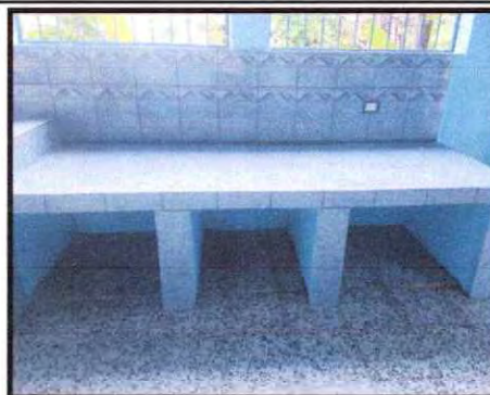
Foto 22: Sustitución de azulejo
