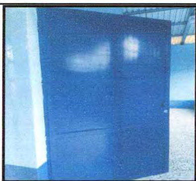
Foto 5: Sustitución de puerta en cocina
