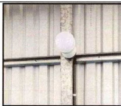
Foto 12: Sustitución de plafoneras
