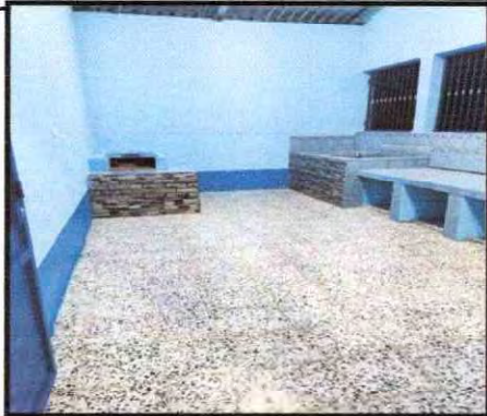
Foto 7: Reparación de piso de granito en cocina
