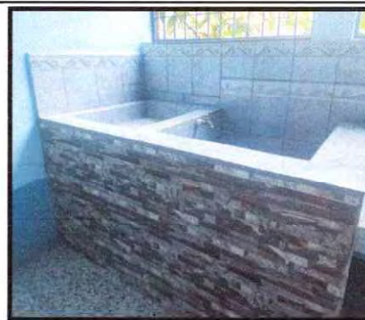
Foto 24: Instalación de pila y 1 lavadero en cocina
