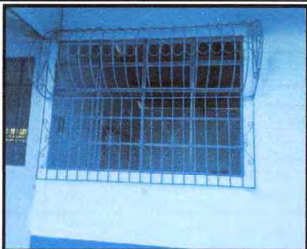
Foto 17: Mantenimiento a balcones de metal
