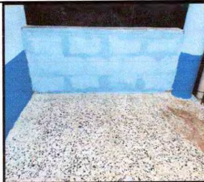
Foto 26: Muro de contención
