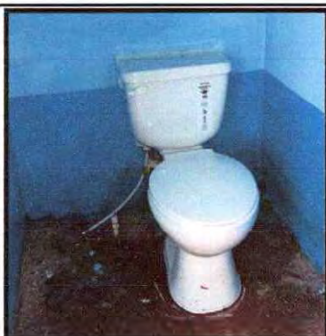
Foto 21: Sustitución de inodoro
