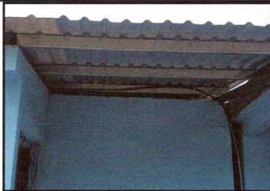
Foto 14: Sustitución de estructura de soporte de madera por metal en baño y bodega
