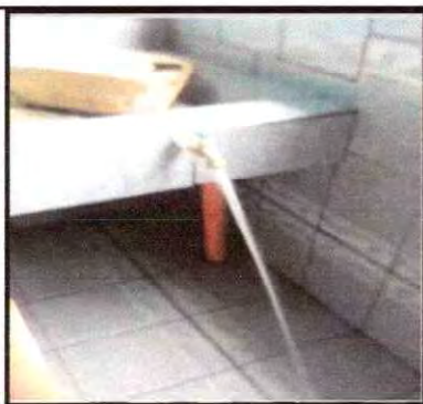
Foto 23: Instalación de tubería para agua potable
