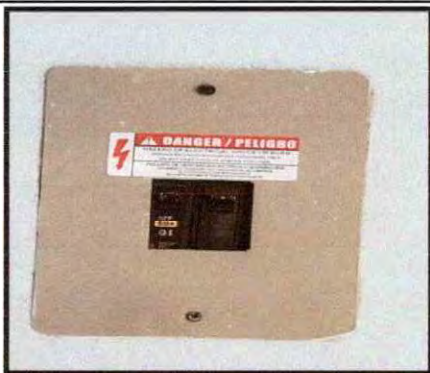
Foto 13: Sustitución de tableros de filipones
