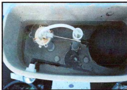
Foto 20: Sustitución de accesorios de inodoro
