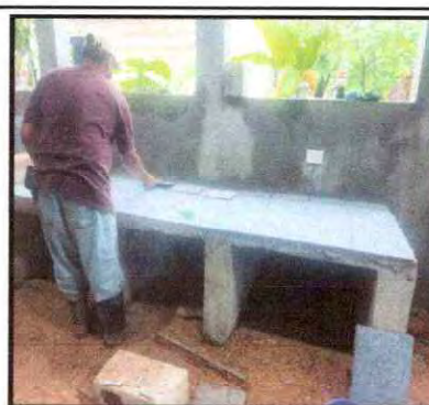
Foto 22: Sustitución de azulejo
