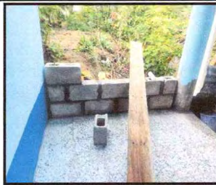
Foto 26: Muro de contención
