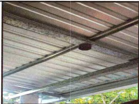
Foto 1: Sustrución de lámina por lámina troquelada aluzinc calibre 26 en en cocina
