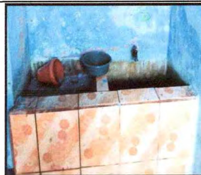
Foto 28: Instalación de azulejo en pila de baños
