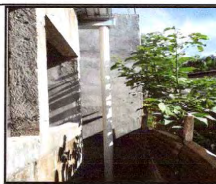
Foto 18: Sustrucción de bajada de agua pluvial de metal por tubo PVC 3"
