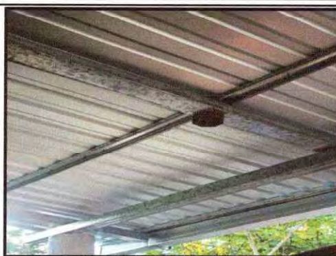
Foto 2: Instalación de lámina troquelada aluzinc en cocina
