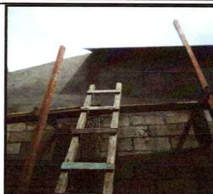
Foto 8: Repello en paredes de cocina
