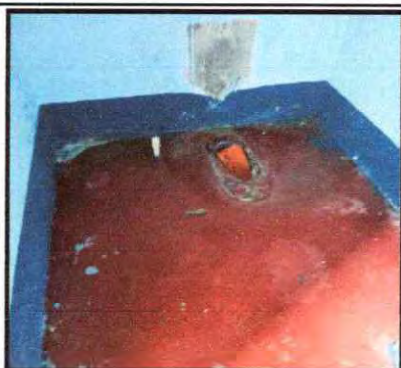
Foto 21: Sustitución de inodoro
