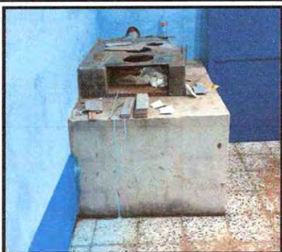
Foto 27: Sustitución de azulejo en estufa rural completa (plancha y chimenea)
