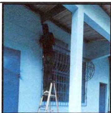
Foto 17: Mantenimiento a balcones de metal
