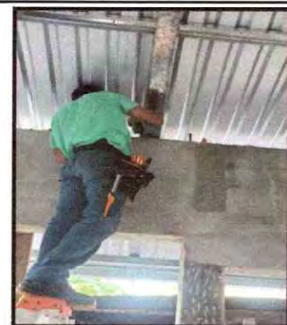
Foto 12: Sustitución de plafoneras
