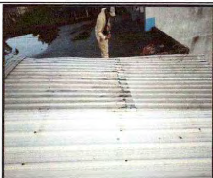
Foto 15: Sustrucción de lámina aluzinc
