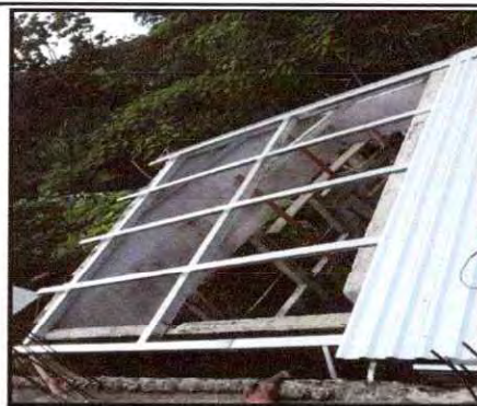
Foto 14: Sustrucción de estructura de soporte de madera por metal en baño y bodega
