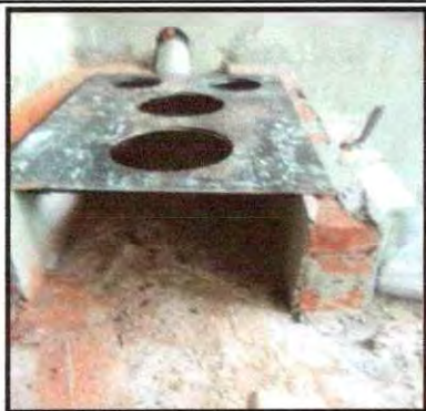
Foto 25: Sustitución de estufa rural completa (plancha y chimenea)
