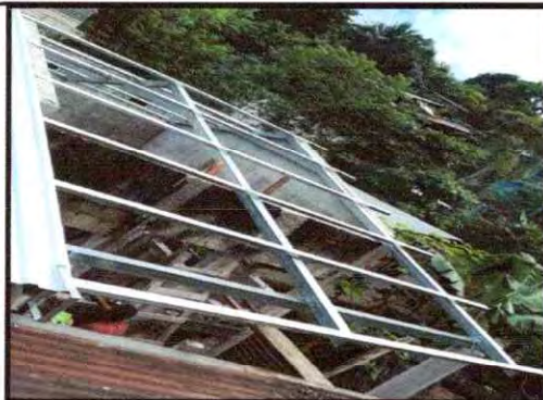
Foto 4: Instalación de Estructura portante
