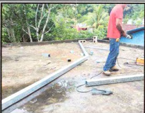
Foto 3: Sustrución de estructura de soporte de madera, por metal
