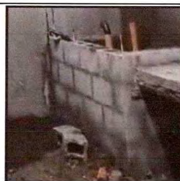
Foto 24: Instalación de pila y 1 lavadero en cocina
