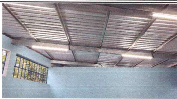
Foto 8: Sustitución de ducto eléctrico + accesorios
