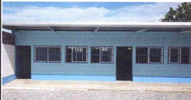
Foto 2: Sustitución de piso de torta de concreto.
