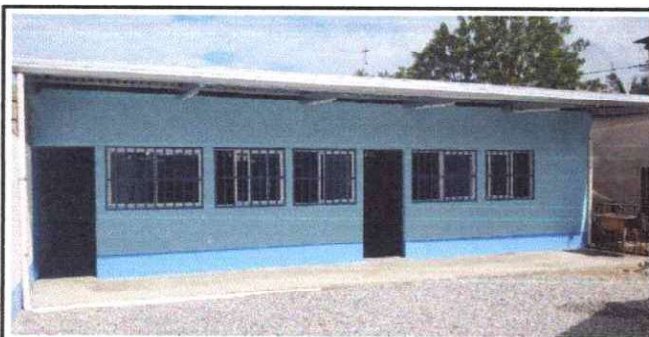
Foto 11: Sustitución de canal de metal.
