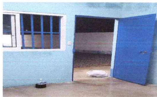
Foto 6: Sustitución de puerta.
