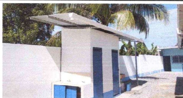
Foto 10: Pintura en muros exteriores e interiores.
