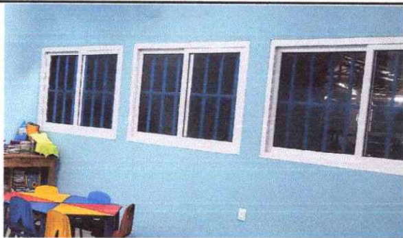
Foto 7: Sustitución de ventanas de madera por metal mas vidrio.
