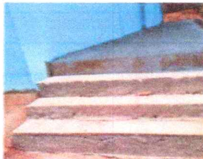
Foto 2: Reparación de banqueta
