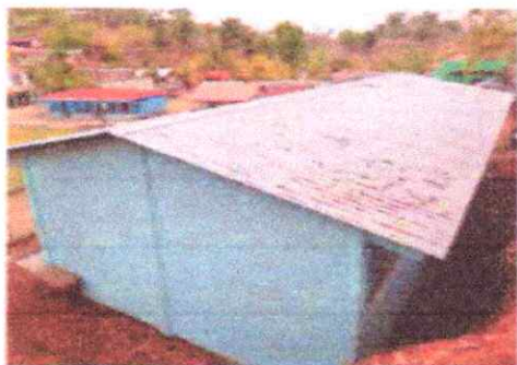
Foto 1: Mantenimiento de estructura y lámina
