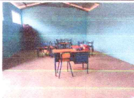
Foto 2: Piso de concreto terminada.
