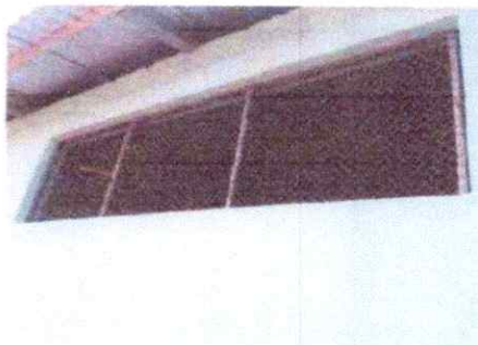
Foto 6: Ventanas de metal
