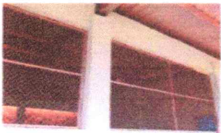
Foto 5: Mantenimiento de ventanas
