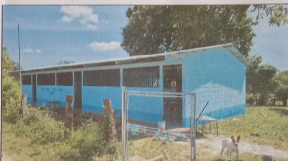
Foto 4: SUSTITUCION DE LAMINA POR LAMINA TROQUELADA
