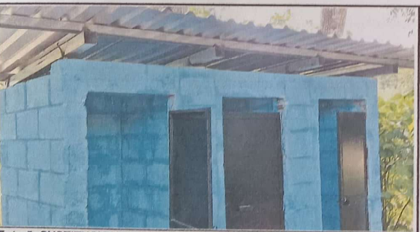
Foto 5: SUSTITUCION DE PUERTAS
