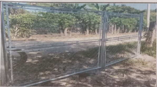
Foto 3: SUSTITUCION DE PORTON DE METAL
