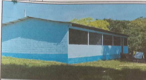
Foto 1: SUSTITUCION DE LAMINA POR LAMINA TROQUELADA
