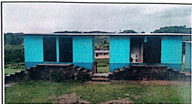
Foto 3: Servicios sanitarios y sus accesorios
