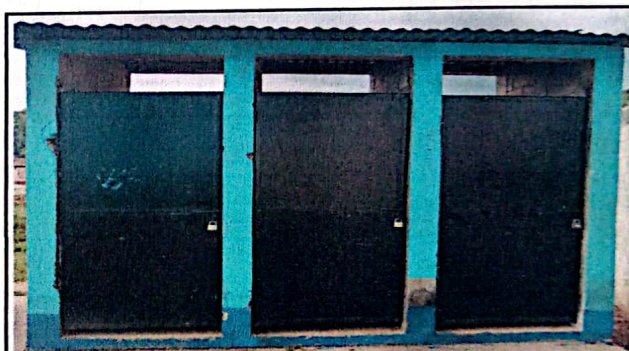
Foto 4: Sustitución de puertas
