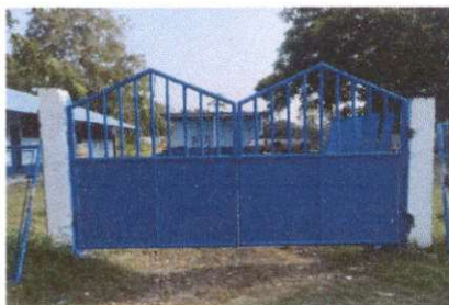
Foto 2: 4.5 Sustitución de portón de metal
