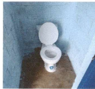
Foto 4: Sustitución de accesorios inodoro (contra llave, tubo de abasto y tanque) y 10.5 Sustitución lavamanos
