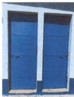
Foto 1: 4.4 Sustitución de puerta en servicios sanitarios
