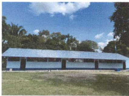
Foto 3: 1.1 Sustitución de lámina, por lámina troquelada aluzinc calibre 26, 1.2 Sustitución de capote de lámina para lámina troquelada y 1.3 Sustitución de elementos de fijación.
