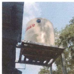
Foto 4: 18.2 Sustitución de depósito de agua 1100 lt y 18.5 Sustitución de accesorios depósito de agua
