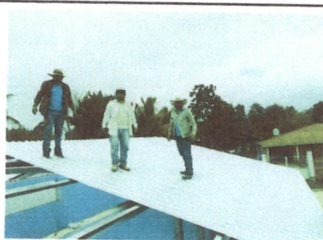
Foto 4: colocando la lámina nueva
