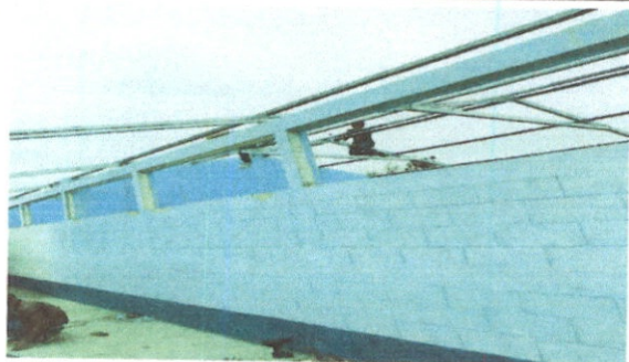
Foto 3: instalación de costaneras de metal
