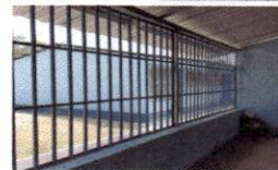
Foto 4: Sustitución de 48 metros cuadrados de balcon de metal.
