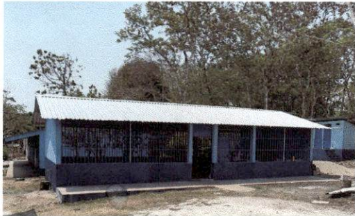
Foto1: Sustitucion de lámina troquelada
