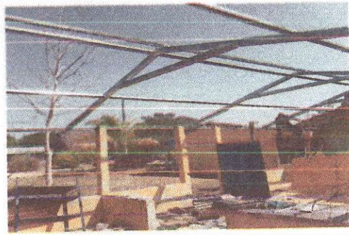
Foto 2: Instalacion de estructura portante de metal
