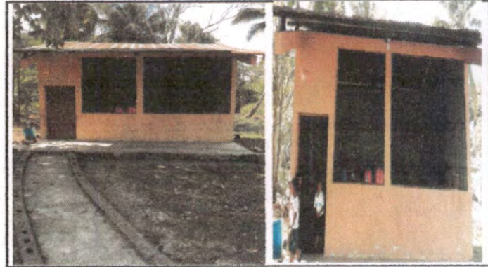
Foto 2: Vista general de como se encuentra el techo, estructura y balcones de aula de parvulos 3.
