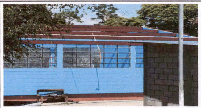
REPARACION Y MANTENIMIENTO DE ESTRUCTURA DE TECHO
