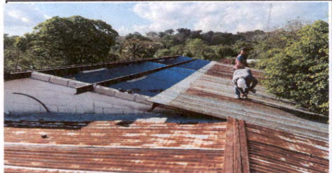
SUSTITUCION DE LAMINA DE TECHO
