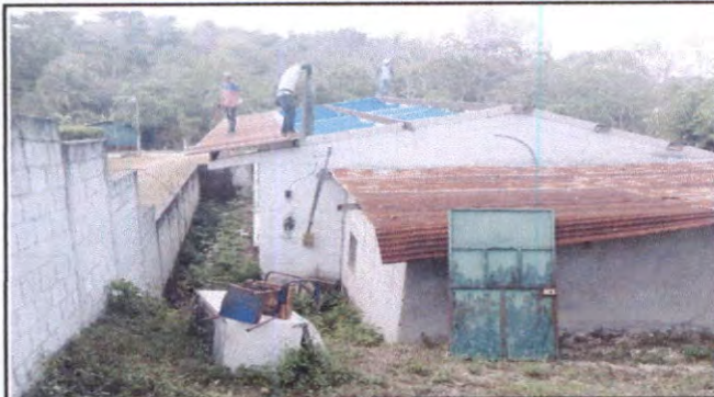
SUSTITUCION DE LAMINA DE TECHO
