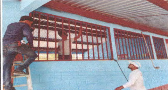
Foto 2: Sustitucion de Lamina por lamina
