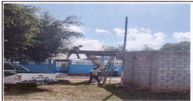
COLOCACION DE LAMINA GALVANIZADA
