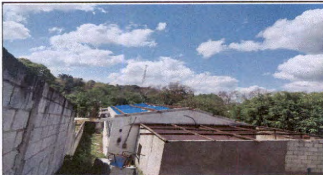
PINTURA EN ESTRUCTURA DE TECHO
