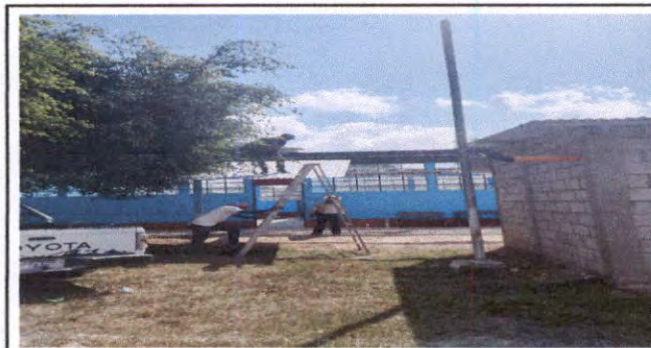
COLOCACION DE LAMINA GALVANIZADA
