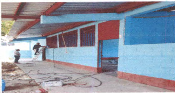
Foto1: sustitucion de estructura de techo
