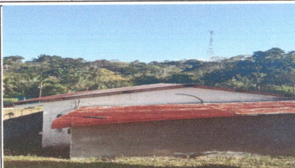
Foto 2: Sustitucion de Lamina por lamina
