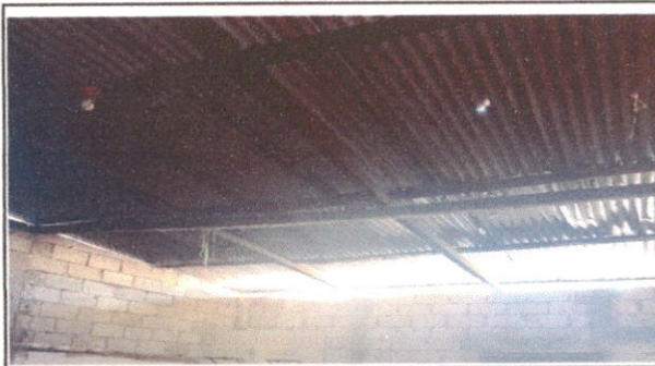
Foto 4: Sustitucion de Estructura
