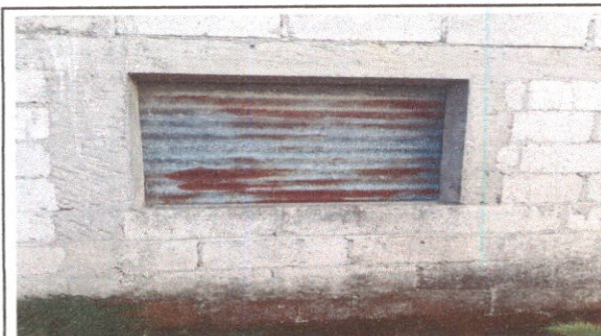
Foto 3: Colocacion de ventana
