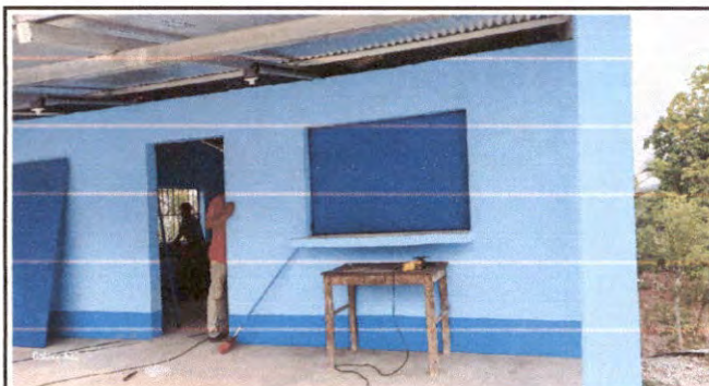
Foto 4: Intalación de ventana en cocina
