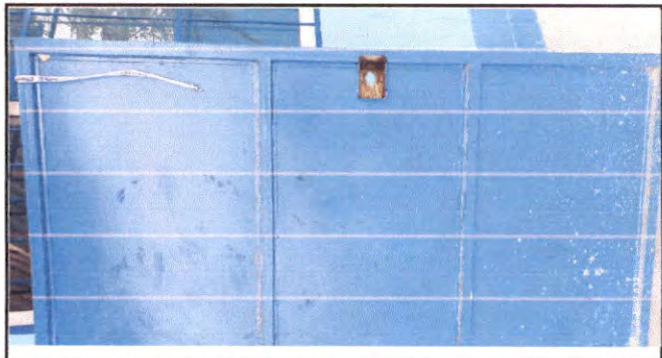
Foto 4: Sustitución de chapas en puerta
