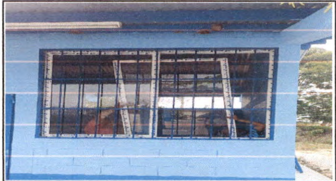
Foto 2: Instalación de ventanas PVC en dirección y ventana
