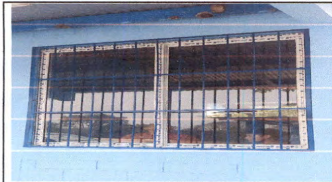
Foto 3: Instalación de ventanas PVC en dirección y ventana
