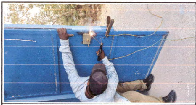
Foto 6: Sustitución de chapas en puertas
