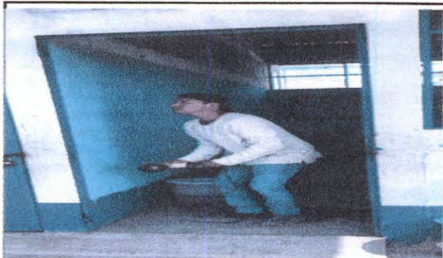
Mantenimiento de puertas
