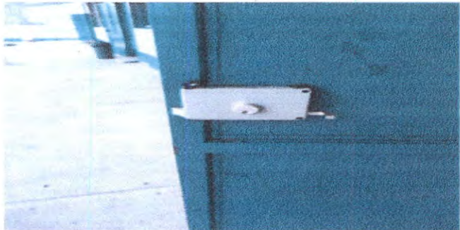
Sustitución de chapas
