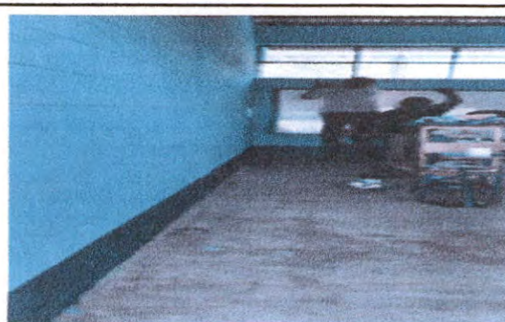
Pintura en exteriores e interiores
