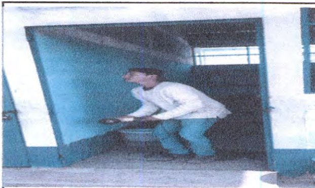
Mantenimiento de puertas
