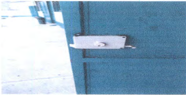
Sustitución de chapas
