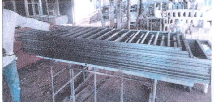
Sustitución de balcones de metal
