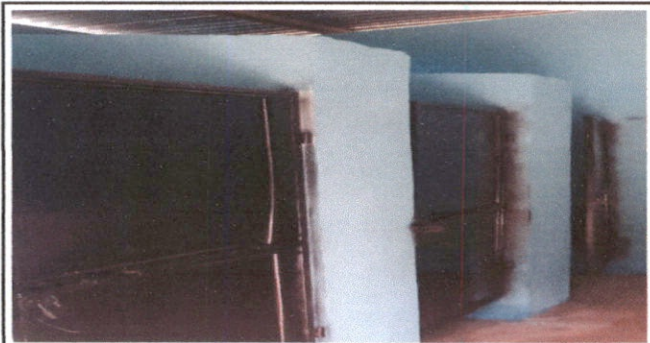
Foto 5: Sustitución de puerta.
