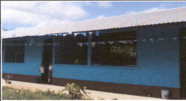
Foto 1: PINTURA EN MUROS INTERIORES Y EXTERIORES.
