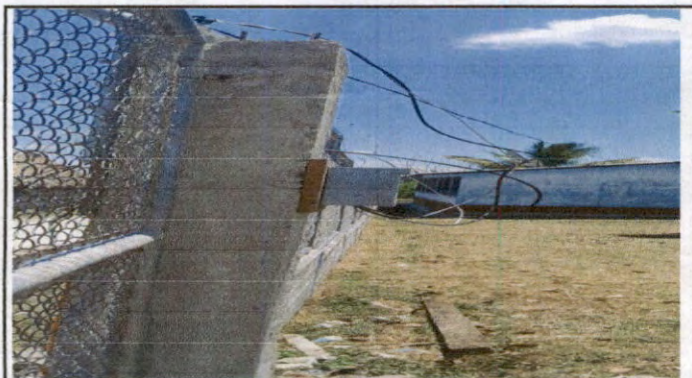
REPARACION Y MANTENIMIENTO DE SISTEMA ELECTRICO
