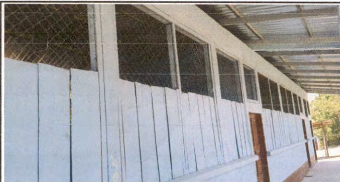
REPARACION Y MANTENIMIENTO DE VENTANAS Y BALCONES
