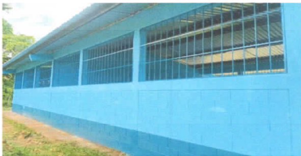
Foto 1: sustitución de balcones
