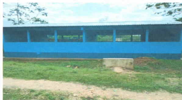
Foto 2: pintura en muros interiores y exteriores.
