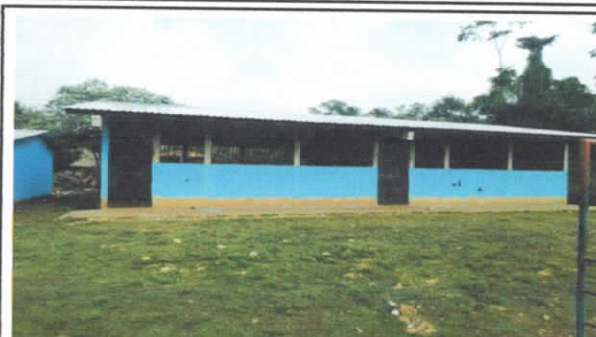
Foto 2: mantenimiento a estructura (lijado cambio de tubocepillado sujeccion aplicacion de pintura)
