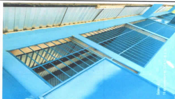
Foto 3: pintura en muros exteriores e interiores
