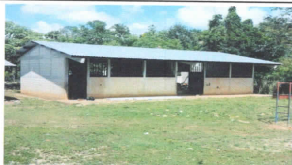
Foto1: sustitución de lamina por lamina troquelado aluzinc calibre 26
