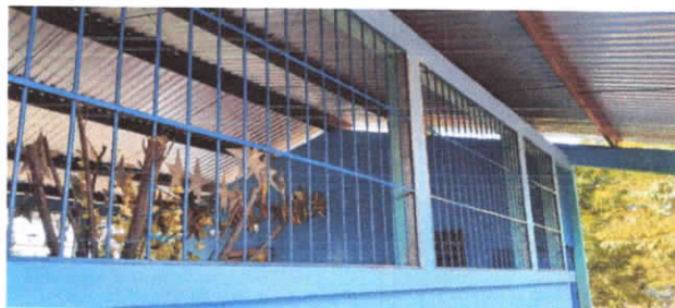
Foto 5: Sustitución de balcones de metal
