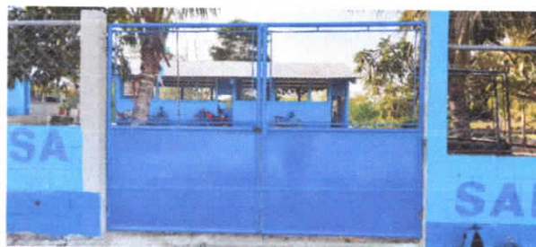
Foto 4: Sustitución de portón de metal
