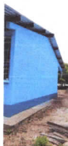
Foto 3: Pintura en muros exteriores e interiores.
