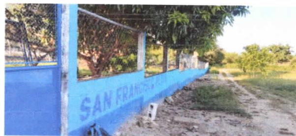
Foto 2: Reparación de tubo hg y malla galvanizada.
