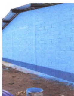
Foto 3: Pintura en muros exteriores e interiores.
