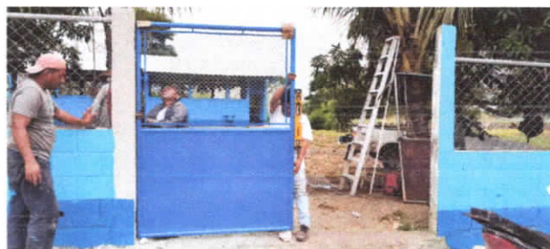
Foto 4: Sustrucción de portón de metal
