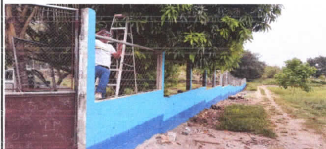
Foto 2: Reparación de tubo hg y malla galvanizada.
