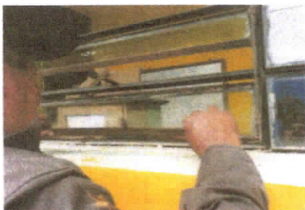
REPARACIÓN DE VENTANAS DE VIDRIO
