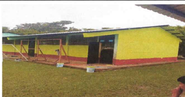
PINTURA EN MUROS EXTERIORES E INTERIORES
