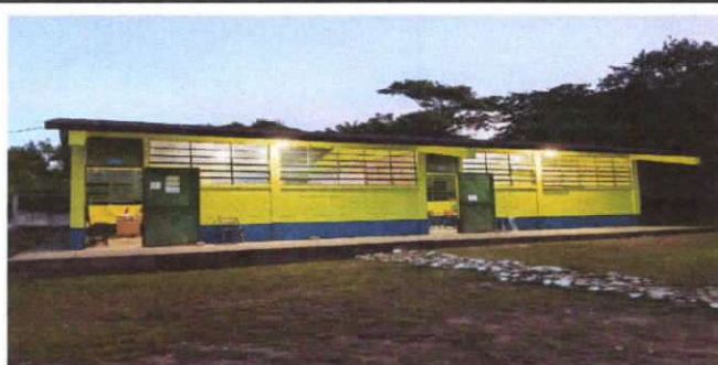
SUSTITUCIÓN DE DUCTO ELECTRICO MAS ACCASORIOS
