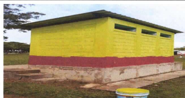
MANTENIMIENTO EN SERVICIOS SANITARIOS
