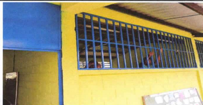
SUSTITUCIÓN DE BALCON DE METAL EN VENTANA
