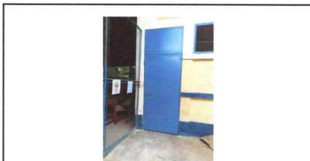
Foto 10: Sustitución de puerta en servicios sanitarios
