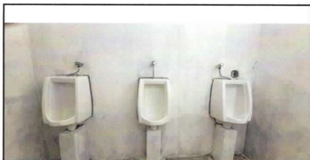
Foto 7: Sustitución de mingitorios
