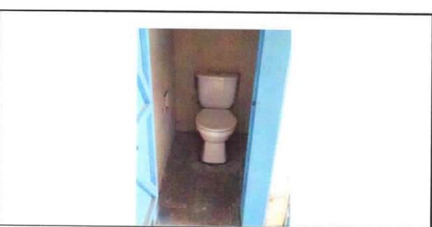
Foto 6: Sustitución de inodoro
