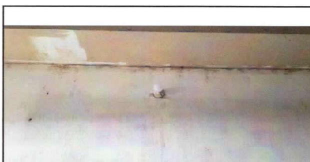
Foto 12: Sustitución de focos ahorradores
