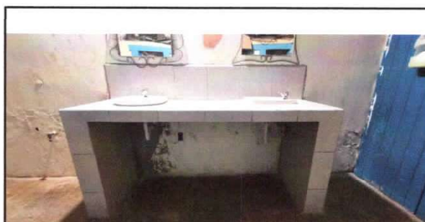
Foto 8: Sustitución de lavamanos
