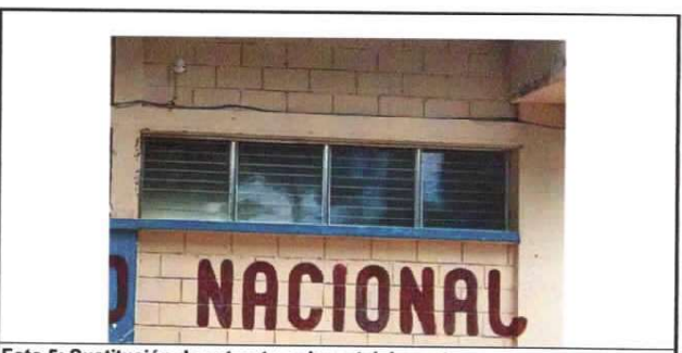
Foto 5: Sustitución de estructura de metal de ventana
