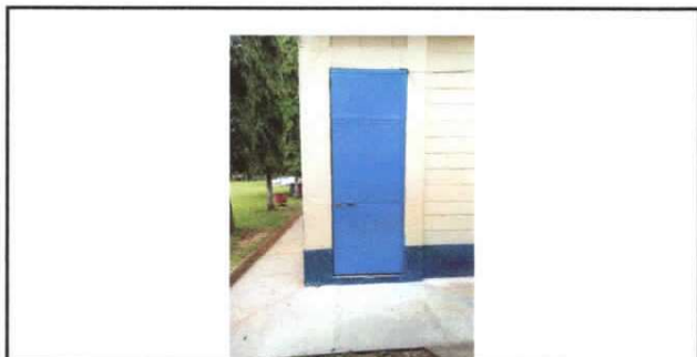
Foto 9: Sustitución de puerta
