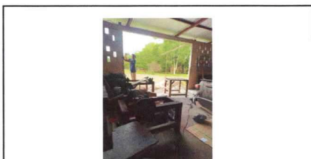
Foto 11: Sustitución de Portón de Metal
