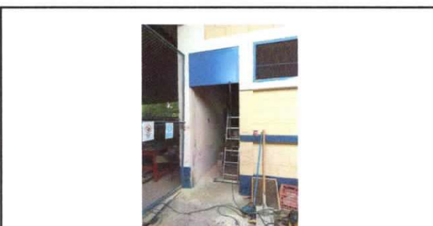
Foto 10: Sustitución de puerta en servicios sanitarios
