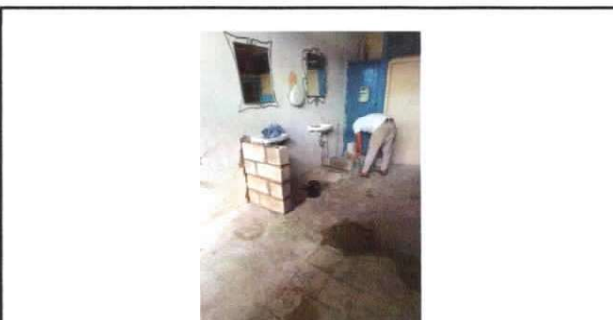
Foto 8: Sustitución de lavamanos
