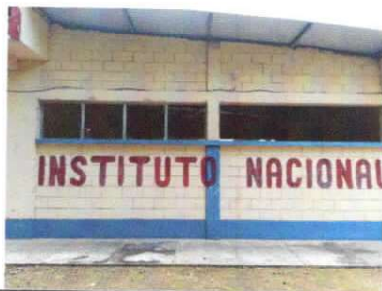
Foto 5: Sustitución de estructura de metal de ventana
