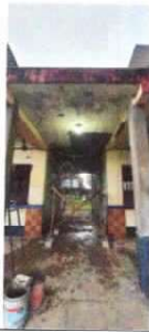
Foto 3: Impermeabilización de losa
