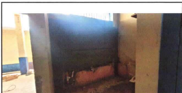
Foto 7: Sustitución de mingitorios
