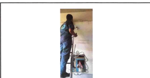
Foto 12: Sustitución de focos ahorradores
