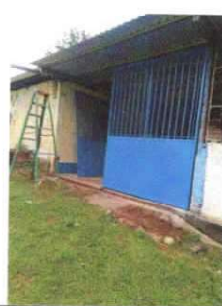
Foto 4: Sustitución de portón de metal
