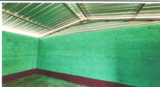
Foto: 1 Pintura de muros de exteriores
