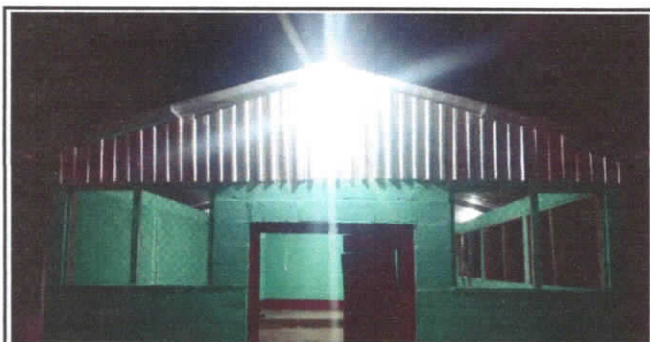
Foto 5: Cambio de cableado eléctrico al salón
