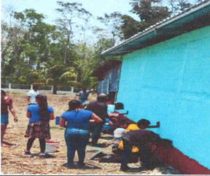
Foto: 1 Pintura de muros de exteriores
