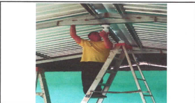
Foto 5: Cambio de cableado eléctrico al salón
