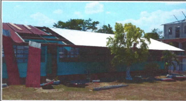
Foto 1: Cambio de lámina de 4 aulas, 2 bodegas y 2 filas de baños.
