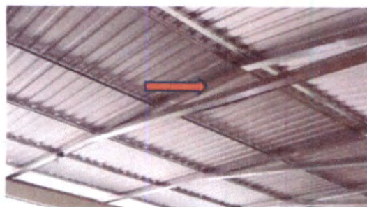
Foto 3: Sustrucción de Cable eléctrico a la parte interior de las aulas del Establecimiento.
