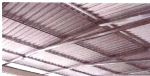
Foto 2: Sustrucción de Cableado Eléctrico en la parte superior del Establecimiento.
