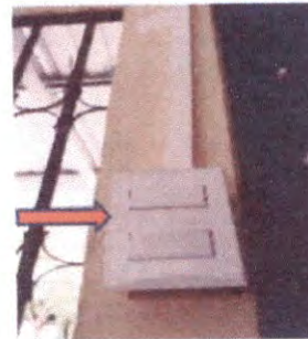
Foto 2: Sustrución de interruptores simples del interior de las aulas del Establecimiento Educativo.
