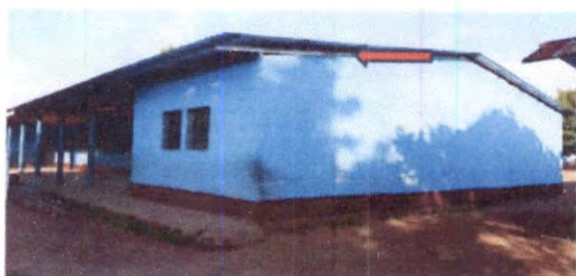
Foto 5: Sustrucción de Cable Eléctrico en la parte lateral derecho del Establecimiento.
