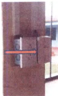
Foto 3: Sustrución de interruptores simples del interior de las aulas del Establecimiento Educativo.
