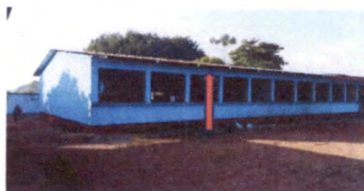
Foto 6: Sustrucción de Cableado Eléctrico parte posterior izquierdo del Establecimiento.
