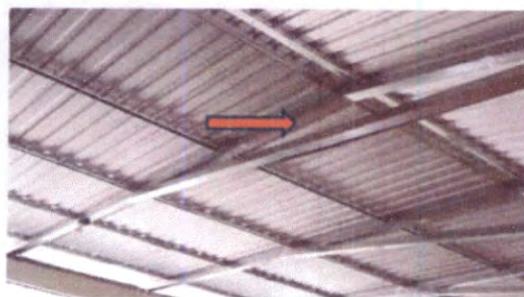
Foto 3: Sustitución de Cable eléctrico a la parte interior de las aulas del Establecimiento.
