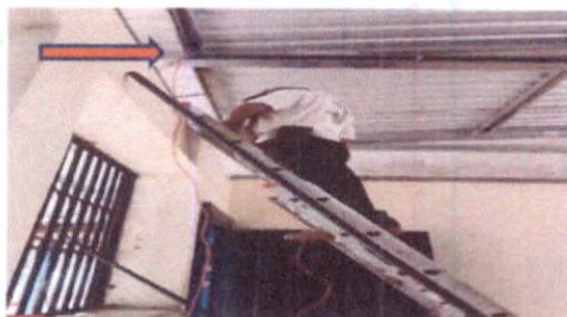
Foto1: Sustitución de Cableado Eléctrico del Establecimiento.
