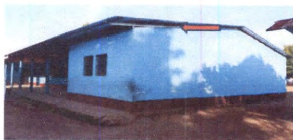
Foto 5: Sustitución de Cable Eléctrico en la parte lateral derecho del Establecimiento.
