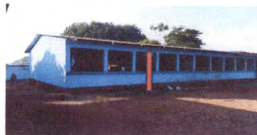
Foto 6: Sustitución de Cableado Eléctrico parte posterior izquierdo del Establecimiento.
