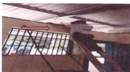
Foto 2: Sustitución de Cableado Eléctrico en la parte superior del Establecimiento.
