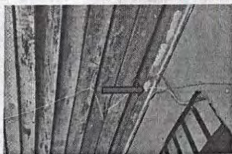
Foto 3: Sustitución de Cable eléctrico a la parte interior de las aulas del Establecimiento.
