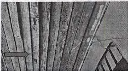
Foto 1: Sustitución de Cableado Eléctrico del Establecimiento.
