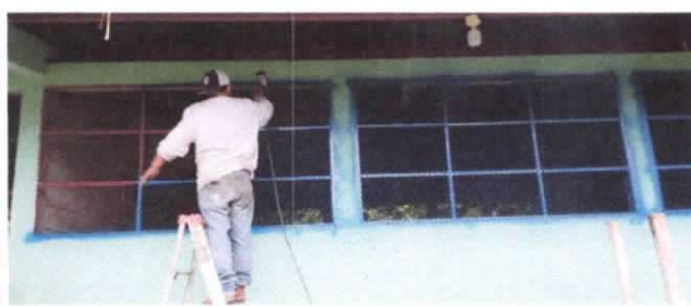
Foto 10: Mantenimiento a balcones de metal
