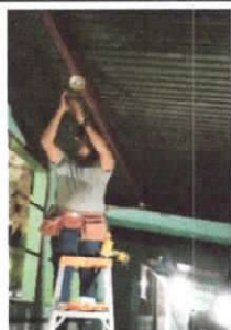
Foto1: Sustitución de focos ahorradores
