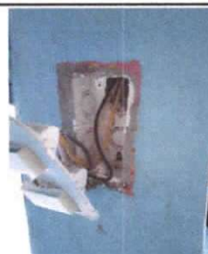
Foto 6: Reparación de cableado eléctrico
