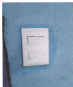
Foto 3:Sustitución interruptores dobles
