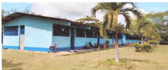
Foto 11: Pintura en muros exteriores e interiores
