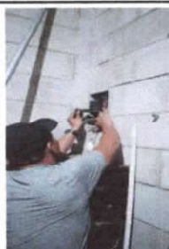
Foto 5:Sustitución de tablero de filpones
