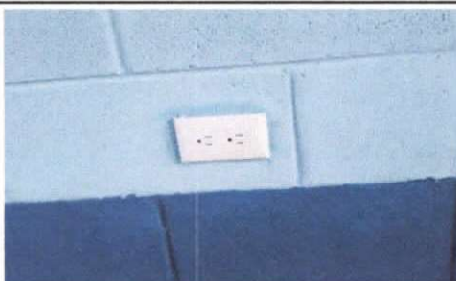
Foto 12: Sustitución de tomacorrientes dobles
