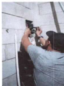
Foto 4: Sustitución de filpones
