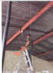
Foto 2:Sustitución de plafoneras
