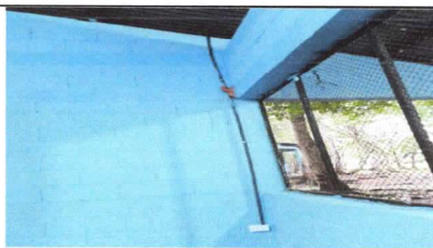
SUSTITUCIÓN DE TOMACORRIENTES DOBLES
