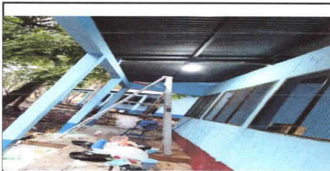
SUSTITUCIÓN DE PLAFONERAS
