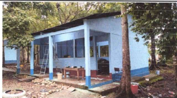
SUSTITUCIÓN DE CABLE PRINCIPAL
