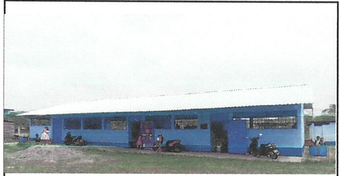
Foto 2: Sustitución de Lamina por lamina troquelada aluzinc calibre 26
