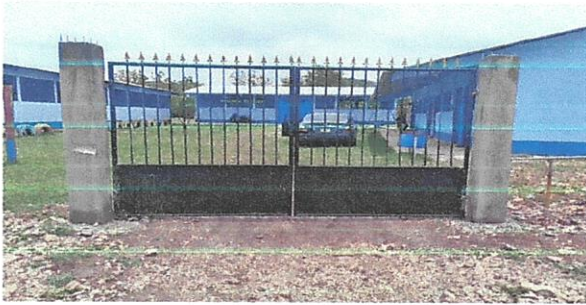
Foto 7: Sustrucción de portón de metal
