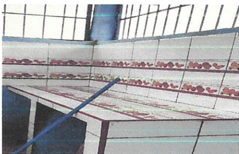
Foto 11: Instalación de azulejo en estufa rural
