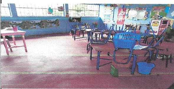
Foto 3: Sustitución de piso de cemento liquido
