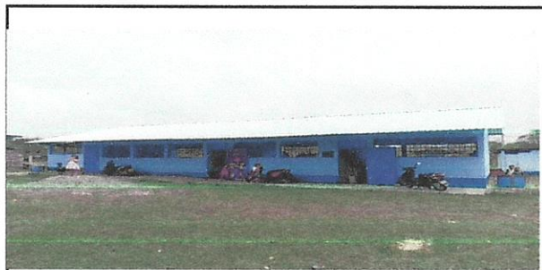
Foto 4: Pintura en muros interiores y exteriores
