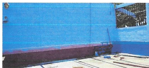
Foto 4: Pintura en muros interiores y exteriores
