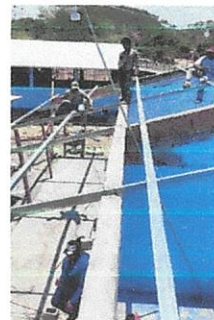
Foto 2: sustitución de lámina por lámina troquelada aluzinc calibre 26
