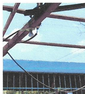
Foto 12: Sustitución de focos ahorradores
