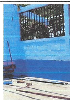
Foto 6: Sustitución de balcones de metal
