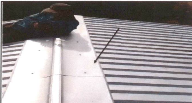
Foto 4: costaneras y laminas nuevas. (Sustitución de capotes de lamina para lámina tróquelada)
