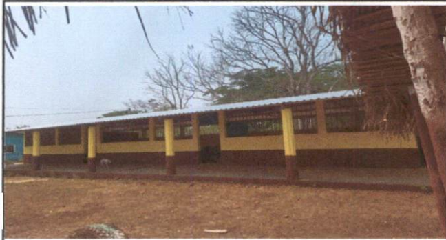
Foto1: Sustitución de lámina, por lámina troquelada alucinc calibre 26
