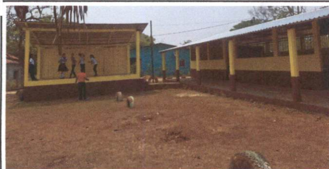
Foto 5: Pintura de muros exteriores e interiores.
