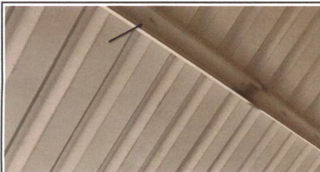
Foto 3: Sustitución de elementos de fijación
