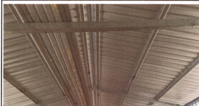
Foto 2: Sustitución de estructura de soporte (madera por metal).
