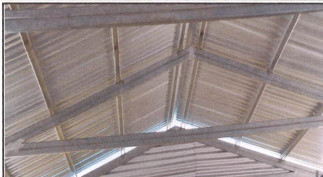
Foto 2: Sustrucción de estructura de soporte madera, por metal.
