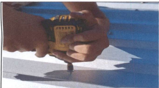
Foto 3: Sustrucción de elementos de fijación
