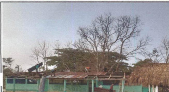
Foto 1: Sustrucción de lámina, por lámina troquelada alucinc calibre 26.
