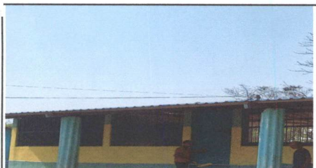
Foto 5: Pintura de muros exteriores e interiores.
